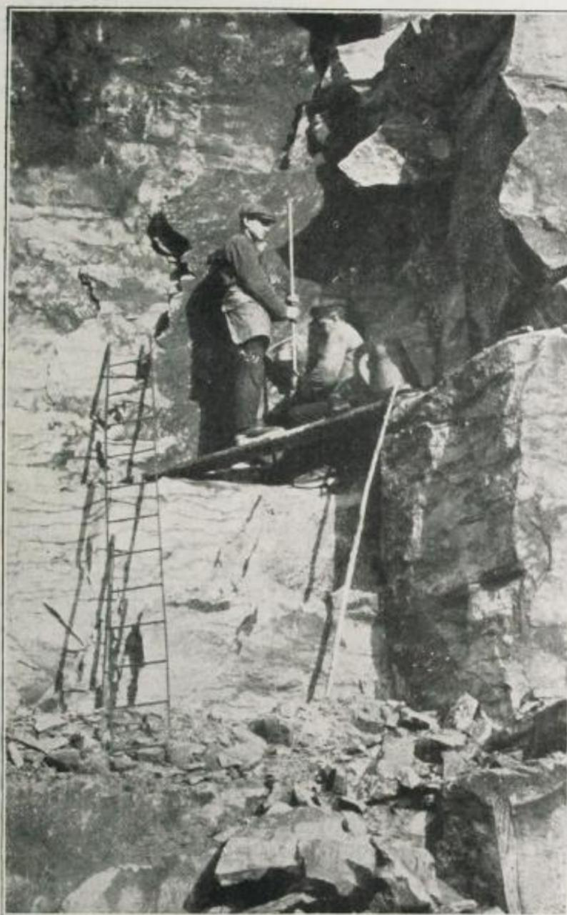
**Bohren unter überhängendem Gestein.** Entgegen allen Vorschriften der Berufsgenossenschaft werden aus Profitgier die lebensgefährlichsten Arbeiten in den Sandsteingruben angeordnet
